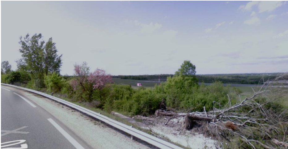
Vue, depuis la RD820, sur la partie Sud-Est du site (talus, terrasses et piste)
