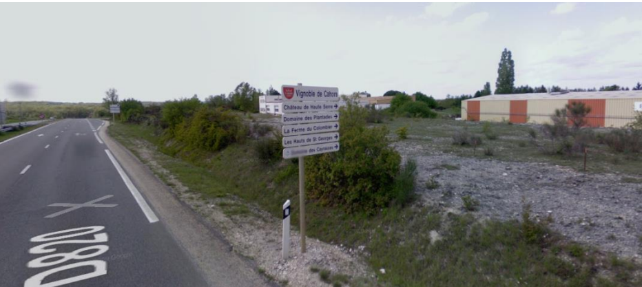
Vue, depuis la RD820, sur le talus et les bâtiments de la ZI de Le Montat
