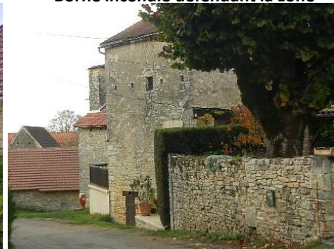
Borne incendie défendant la zone
